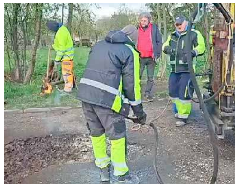
Póki co doszło do cząstkowych napraw drogi osiedlowej
