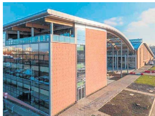
Nowy budynek dydaktyczny UPJPII połączony z biblioteką
