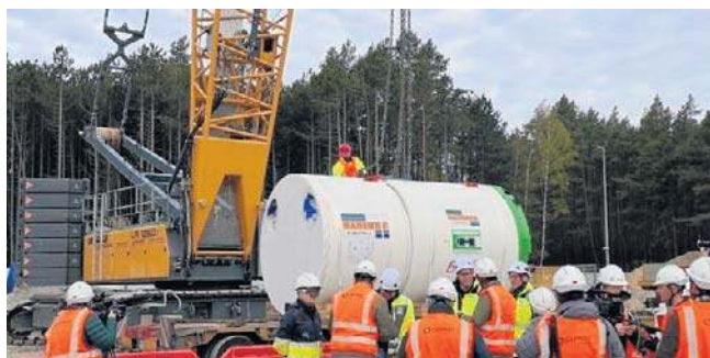
Basia trafi do komory startowej mikrotunelu
