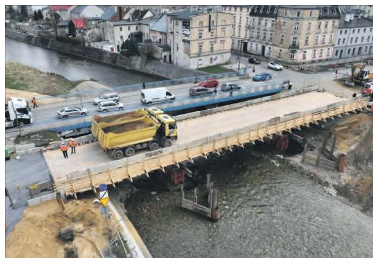
Most tymczasowy i właściwa przeprawa, która wkrótce zostanie rozebrana i zastąpiona nową
