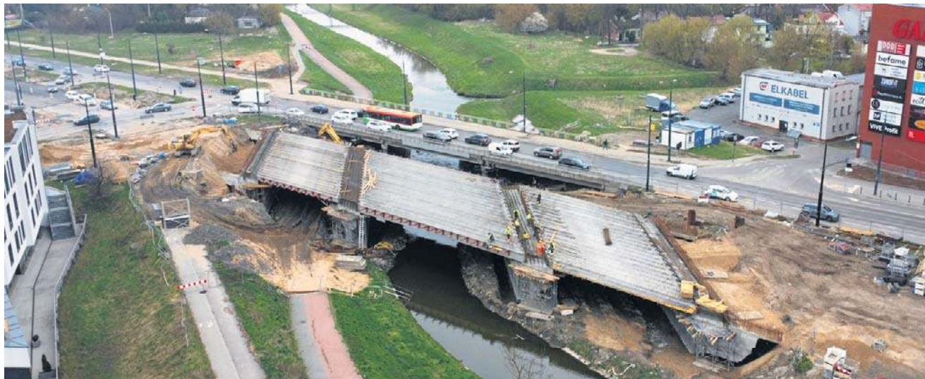
Konstrukcja nośna, po której będą jeździć pojazdy, została ułożona z 60 prefabrykowanych belek. Niektóre z nich ważą po 28 ton
