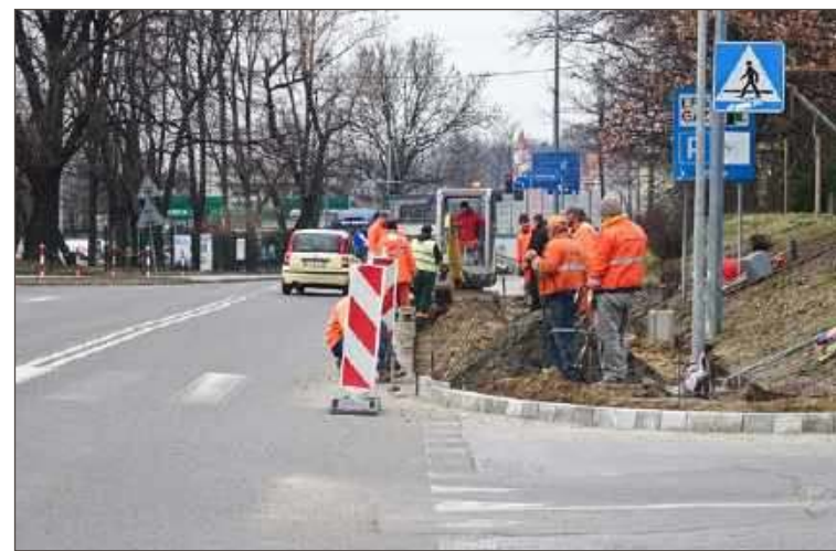
Obecnie trwa przebudowa chodnika i budowa przejścia przy ul. Kościuszki.
