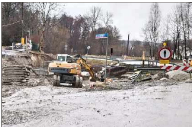
Prace na potoku Zawadka mają zwiększyć bezpieczeństwo mieszkańców.
