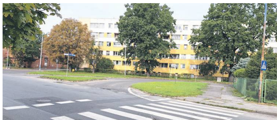
To skrzyżowanie w Oławie będzie przebudowane
