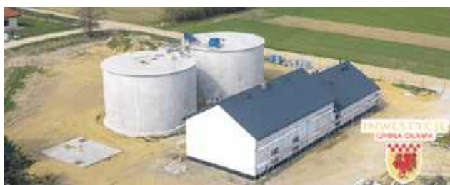
Stacja Uzdatniania Wody w Siedlcach
