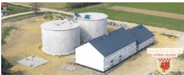
Stacja Uzdatniania Wody w Siedlcach
