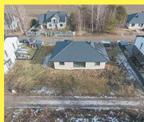
Dom z pompą ciepła i fotowoltaiką - Porosiuki, 604 494 489
