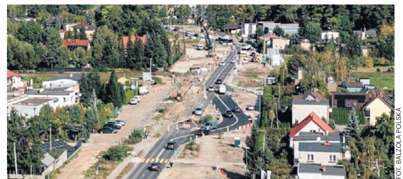
Rozpoczęły się prace przy budowie przyczółków wiaduktu
