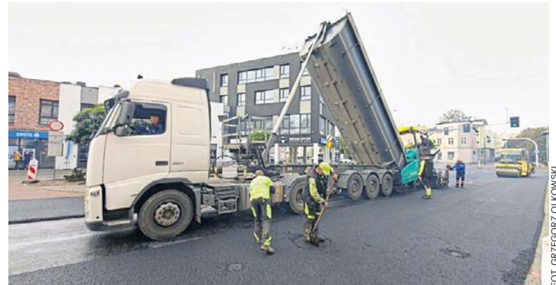
Na czas układania nowej, asfaltowej nawierzchni północna jezdnia Kościuszki została całkowicie wyłączona z ruchu
