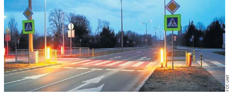
Słupki LED ostrzegają kierowców o obecności przechodniów na przejściach dla pieszych w Toruniu
