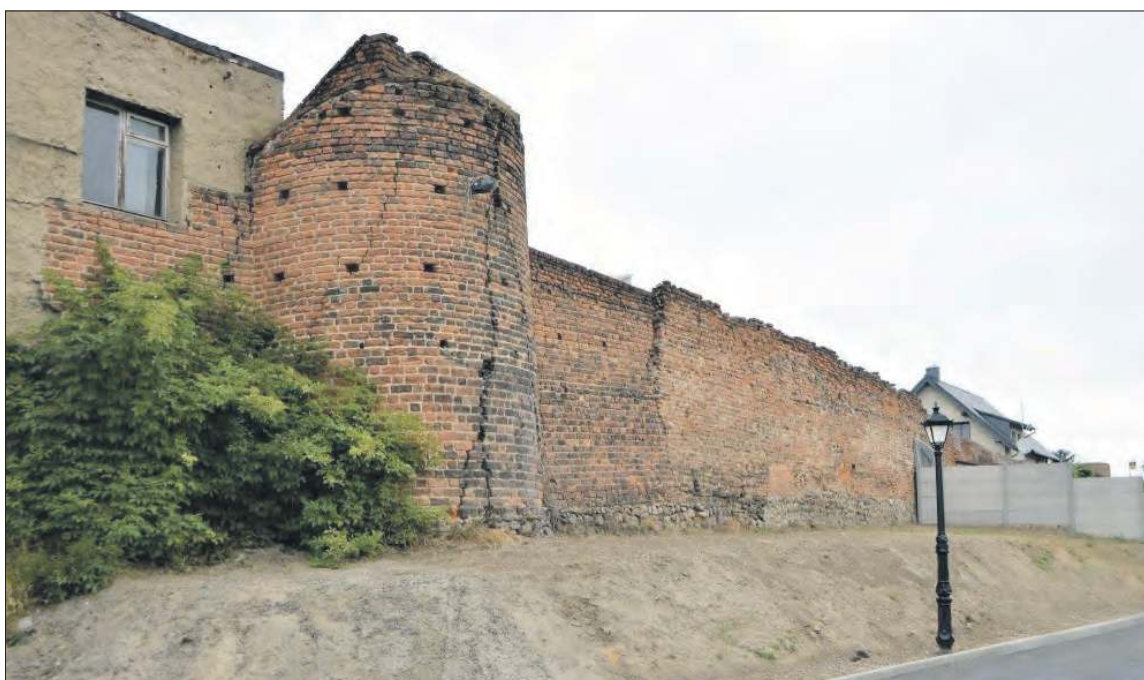
Odremontowany zostanie odcinek murów obronnych
