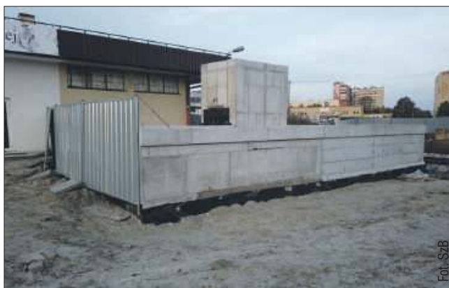
Ukończono już wejście, a także szyb windy.
