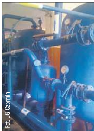
Fot. UG Czermin Stacja uzdatniania wody w Trzcianie zostanie przebudowana.
