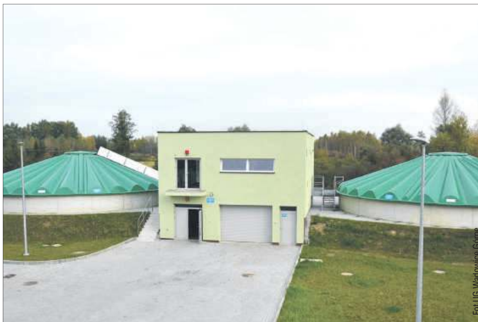
Przebudowa dotychczasowej oczyszczalni ścieków i rozbudowa sieci kanalizacyjnej to największe pod względem wartości inwestycje realizowane do tej pory przez gminę Wadowice Górne.
