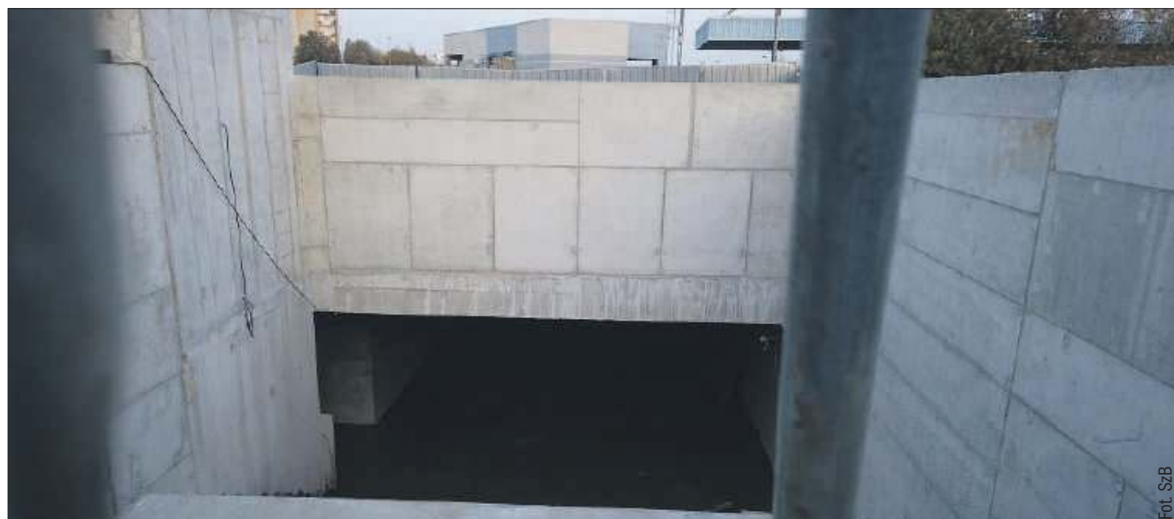
Wykonano już pierwszą część tunelu. Cała inwestycja ma być zakończona w przyszłym roku.
