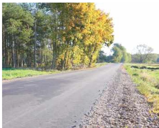
Na początku października został dokonany odbiór najdroższej inwestycji, remont odcinka o dł. 1,700 km w Krasewie
