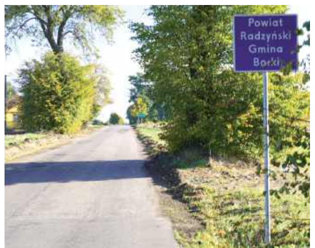
Początek remontu drogi powiatowej nr 1252L Tchórzew – Górka Kocka na odcinku o długości 1,229 km
