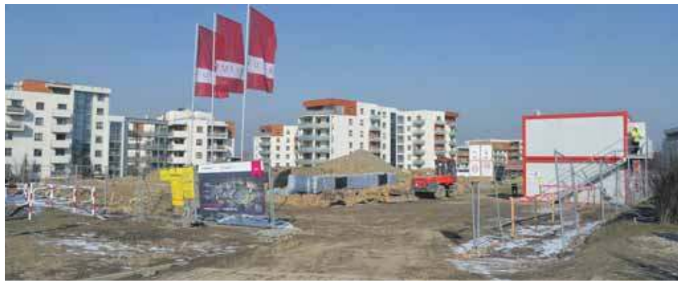
Obecnie prowadzone są prace ziemne i przygotowawcze pod fundamenty budynków
