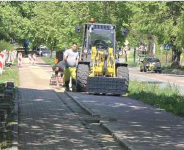
W ubiegłym tygodniu pracownicy Rejonu Dróg Wojewódzkich w Puławach rozpoczęli prace związane z usuwaniem krawężnika oddzielającego ścieżkę rowerową od chodnika wzdłuż ul. Kazimierskiej
