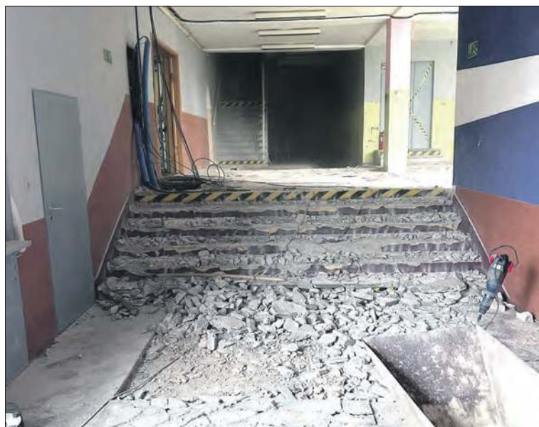
Korytarz w trakcie prac remontowych
