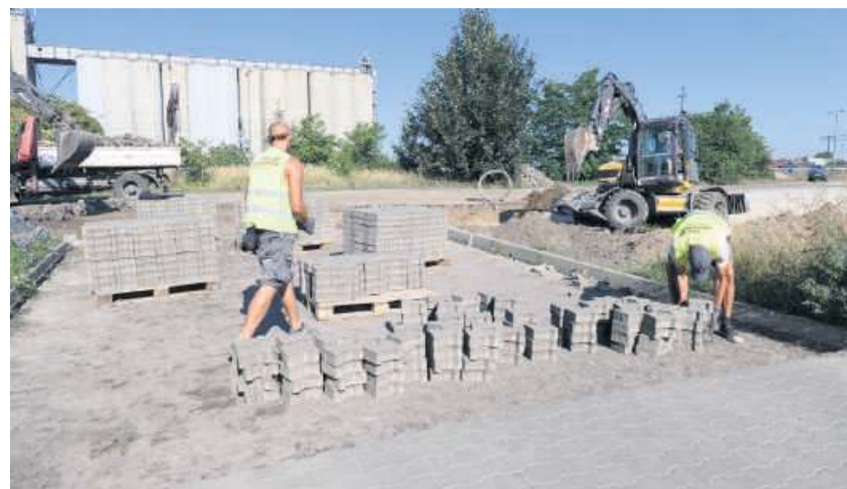
Wykonany z kostki betonowej fragment ulicy Przedszkolnej musi zostać rozebrany, aby połączyć tę ulicę z powstającą ulicą Piastów Śląskich
