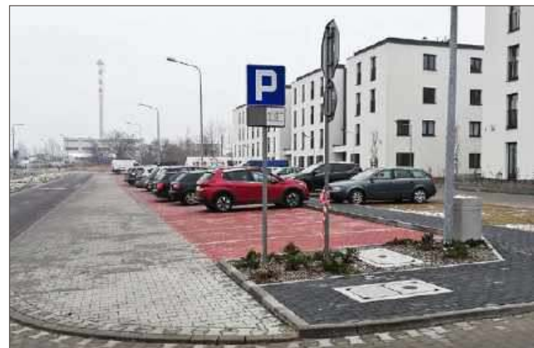
By wjechać, bądź wyjechać z parkingu należy przejechać po chodniku.
