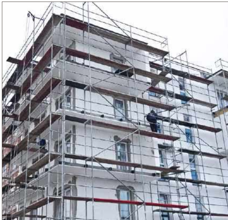
Kolejny blok buduje się przy ul. Akademickiej.
