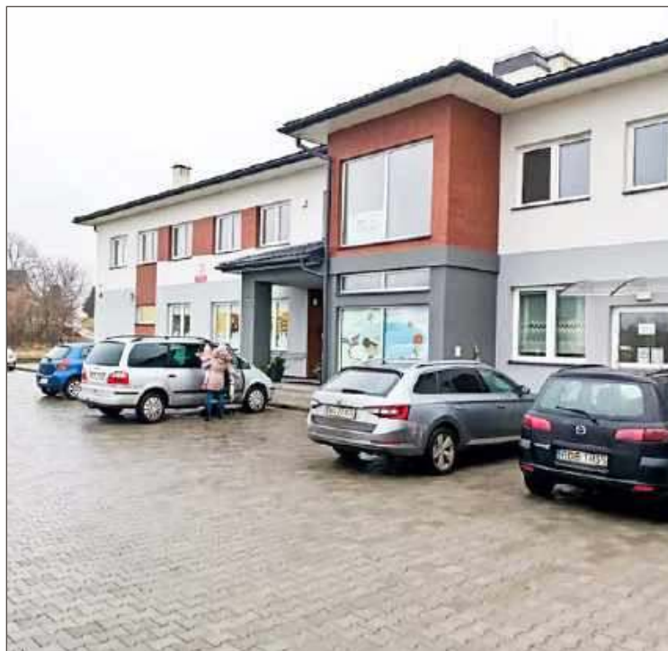
Gmina przeznaczy 300 tys. zł. na wyposażenie budynku w Zawierzbiu.
