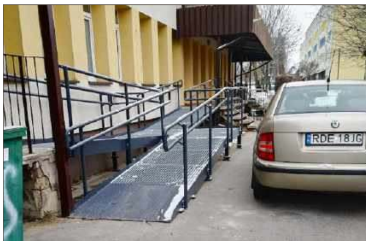
Budowa podjazdu już się zakończyła.
