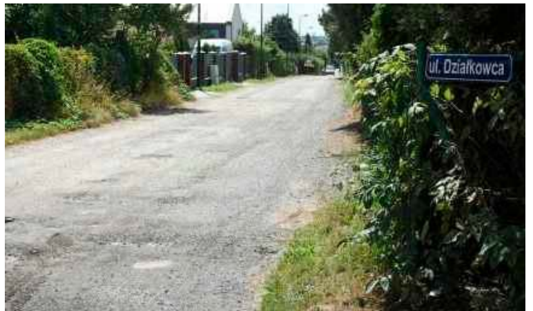
Budowa ulicy Działkowca będzie prawie dwukrotnie droższa niż zakładało miasto
