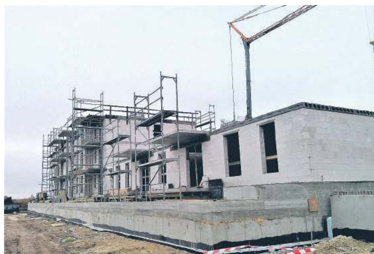
Budowa bloku mieszkalnego Towarzystwa Budownictwa Społecznego w Chełmie
