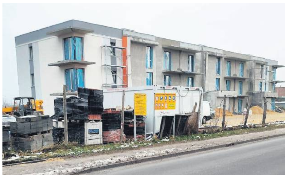
Budynek z mieszkaniami z niskim czynszem przy ul. Glinianej w Strzelinie jest w trakcie budowy
