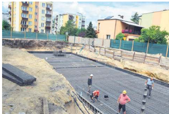
Drewniany budynek dawnej szkoły został już rozebrany.
