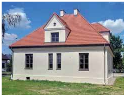
...i po zakończeniu prac budowlanych
