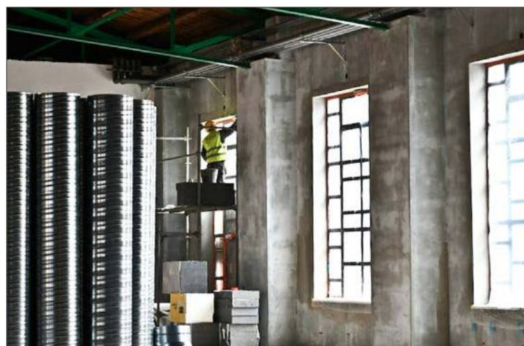
W hali przy ulicy Kościuszki prace są już mocno zaawansowane.
