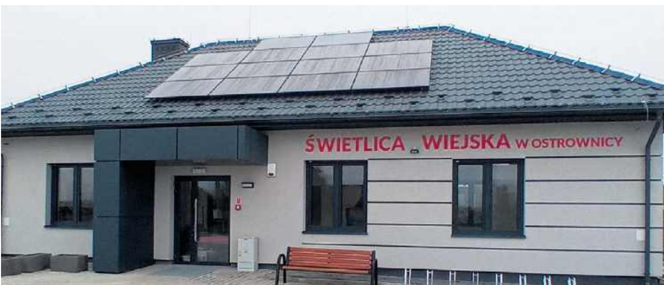
Nowa świetlica wiejska w miejscowości Ostrownica
