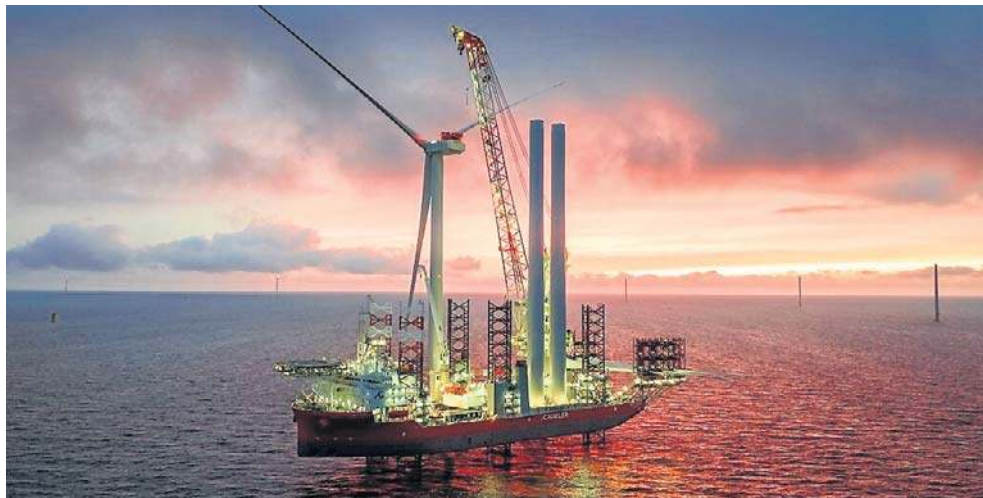
Instalacja turbin na farmie Baltic Power. Najprawdopodobniej w drugiej połowie roku popłyną z nich pierwsze dostawy energii elektrycznej.
