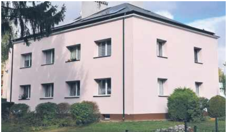
Blok przy ul. Leśnej po modernizacji
