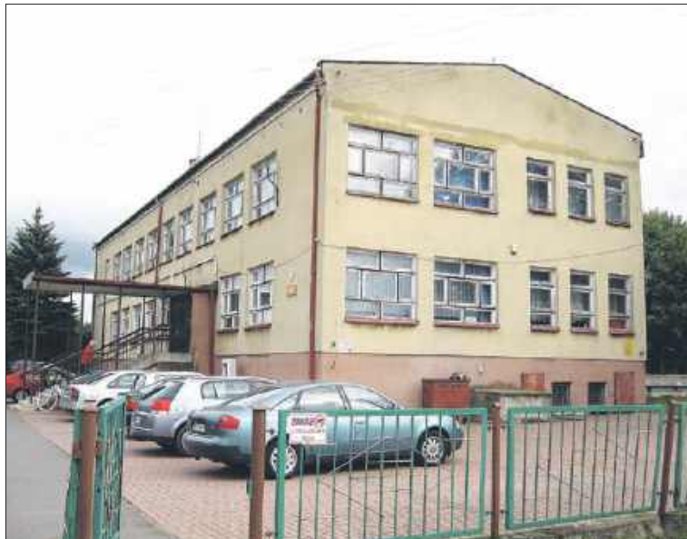
W dotychczasowym budynku przedszkola powstanie po modernizacji 20 lokali socjalnych
