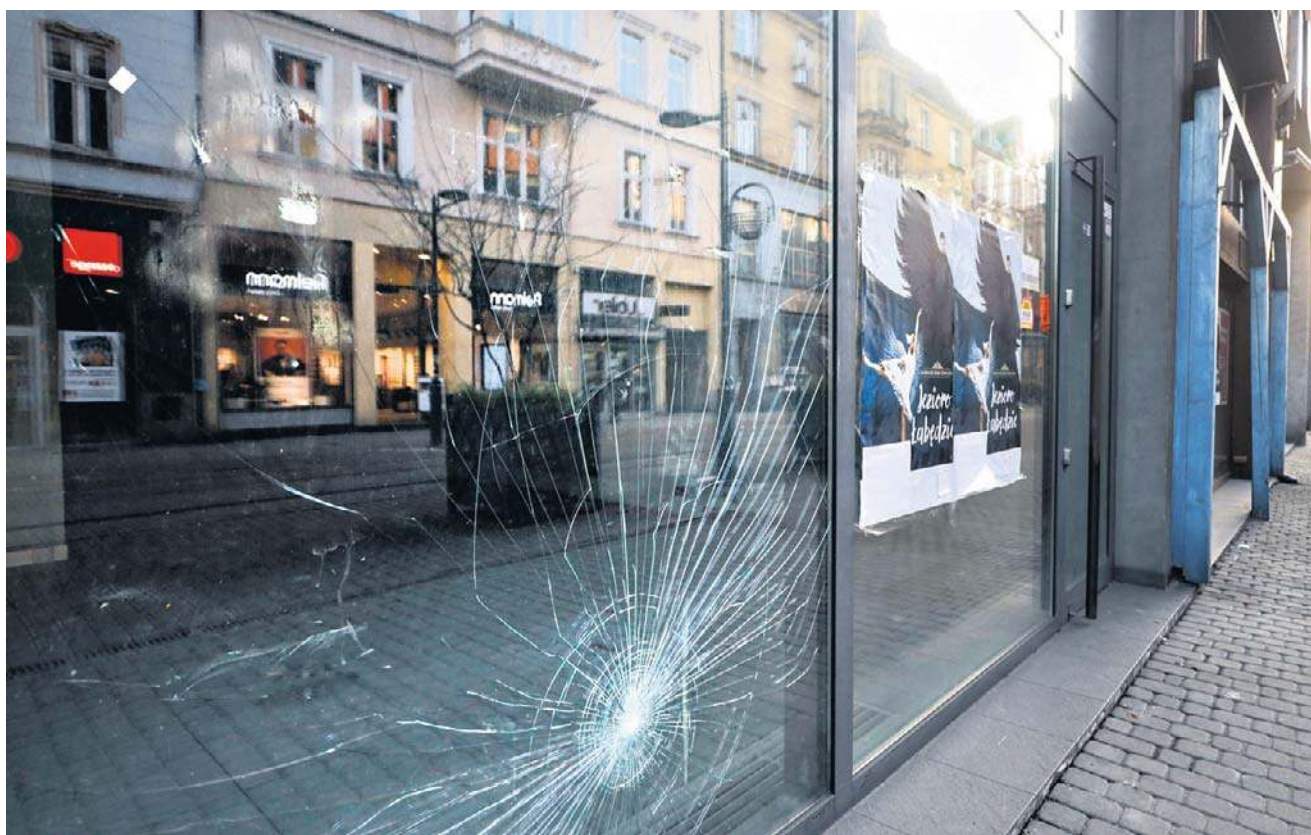
Taki widok pustych, podniszczonych witryn sklepowych przy ul. Wolności w Chorzowie niestety nie jest rzadkością
