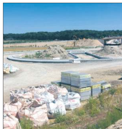
Tak wygląda budowa ekspresówki pod Komarowem-Osadą.
