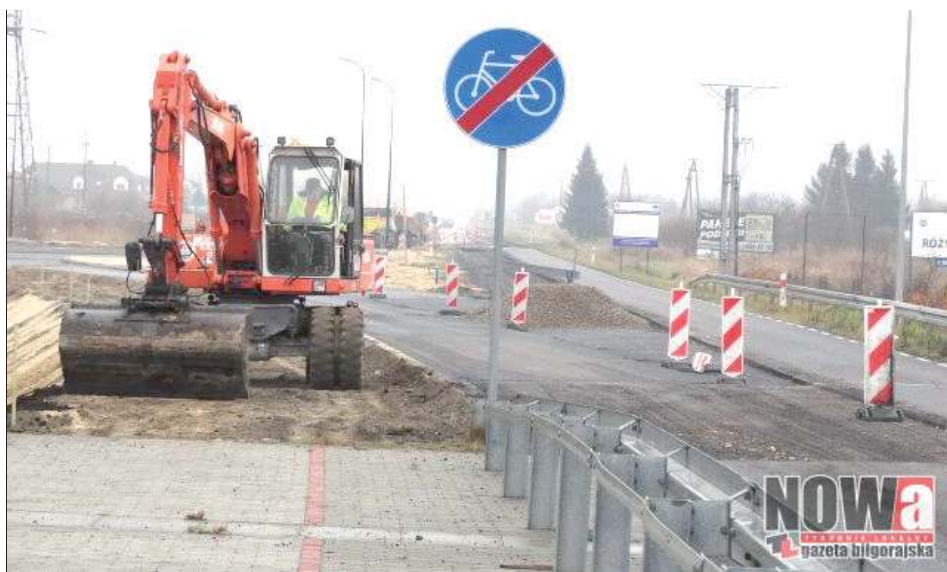
Droga Księżpol-Harasiuki idzie do remontu
