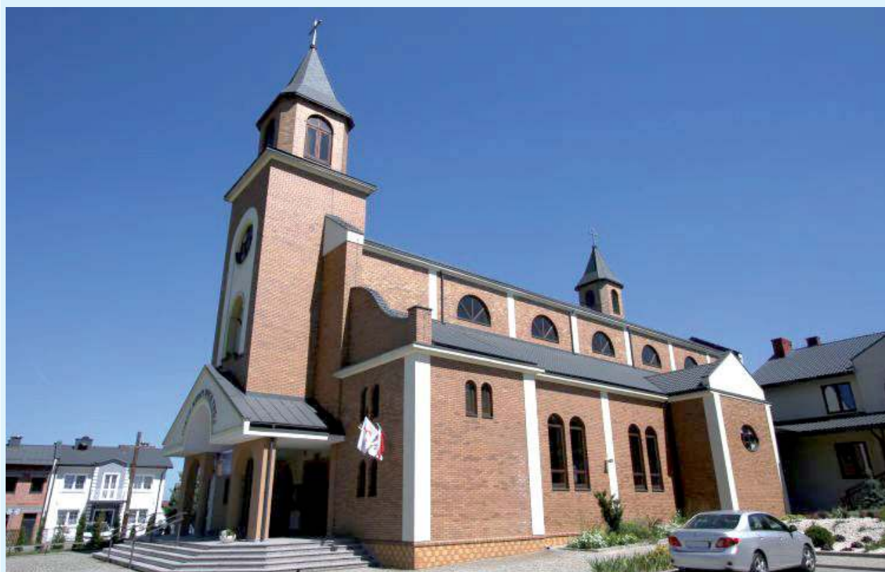
Budowa kościoła przy ul. Poniatowskiego w Biłgoraju rozpoczęła się w 2006 roku
