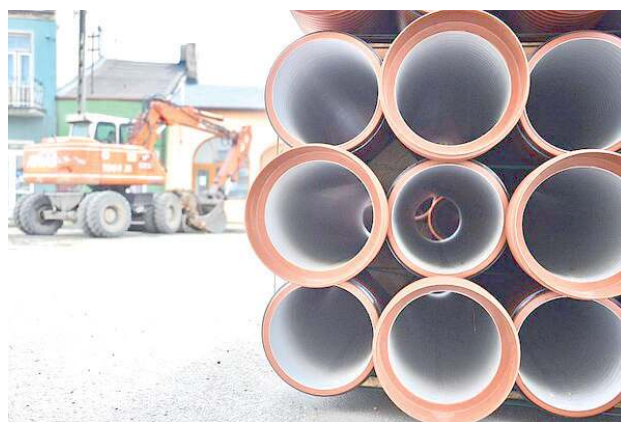
Ponad 2,5 kilometra nowych rur kanalizacyjnych pojawi się po północnej stronie Babic
