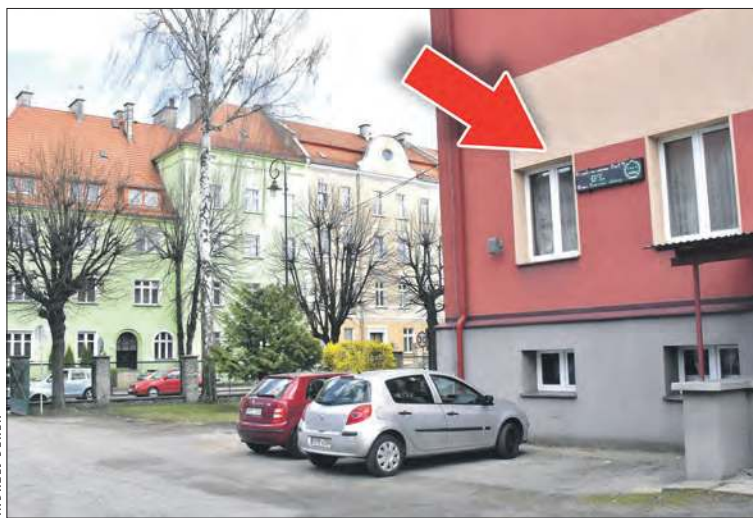
Tablica znajduje się na ścianie zewnętrznej budynku Szkoły Podstawowej nr 4 od strony skrzyżowania ulic Kościuszki i Dąbrowskiego
