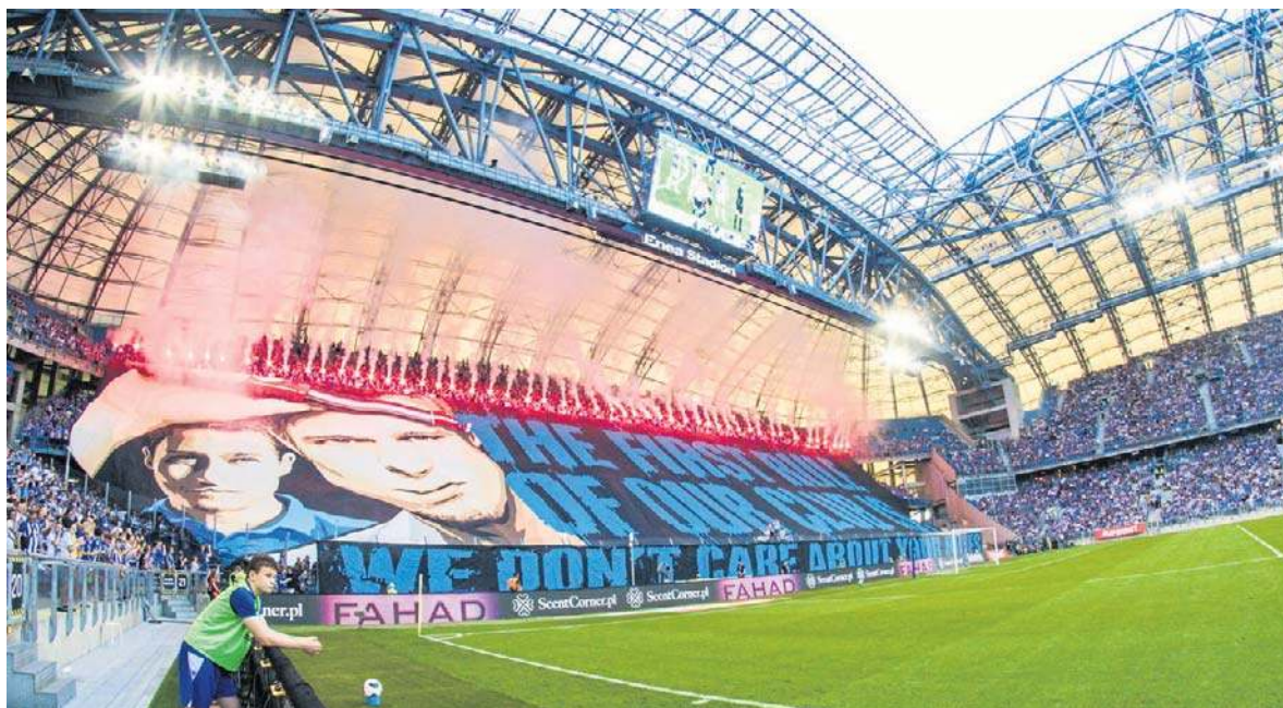
Łukasik: – Mamy kibiców na poziomie Ligi Mistrzów, super stadiony, ale poziom sportowy pozostaje daleko
