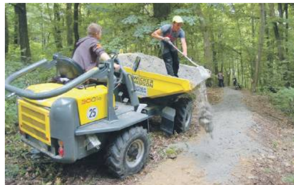
W 2018 roku rozpoczęto budowę ścieżek rowerowych typu singletrack na terenie gminy Strzelin. Fot. archiwum Słowa Regionu
