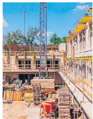
Budowa osiedla na Dołach jest mocno zaawansowana
