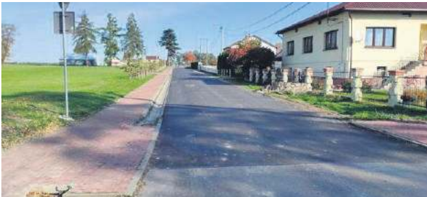
Przy drogach powiatowych wybudowane zostaną chodniki.
