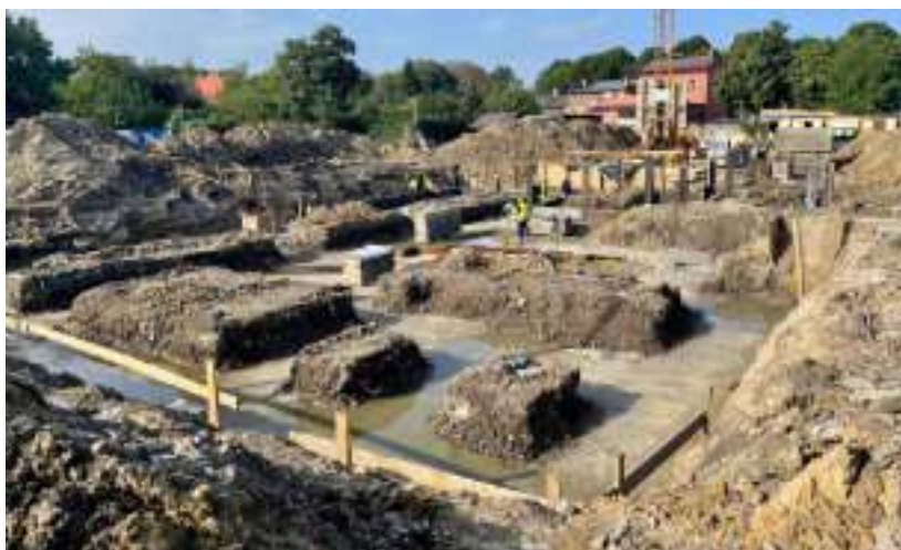
► Prace budowlane trwają aktualnie przy ul. Żeromskiego Fot. UM Zabrze
