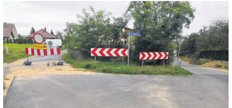
Jest nadzieja, że z końcem listopada ul. Akacjowa w Gęsińcu zostanie oddana w całości do użytku. Właśnie ogłoszono przetarg na odbudowę zawalonego przepustu
