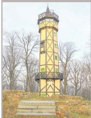
Wieża widokowa na Gromniku jest zamknięta dla zwiedzających
