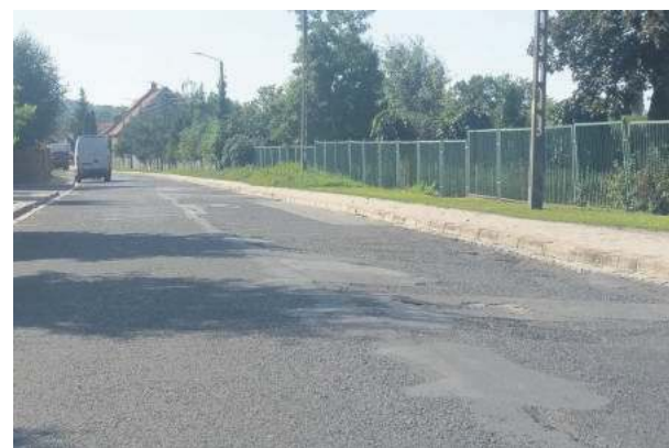
Prace na ul. Konopnickiej obejmują remont nawierzchni jezdni
