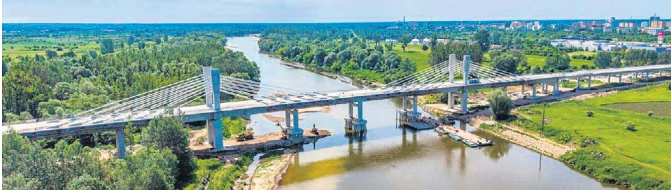
Nowa przeprawa jest częścią strategicznej inwestycji drogowej obejmującej budowę nowego odcinka drogi wojewódzkiej nr 855
