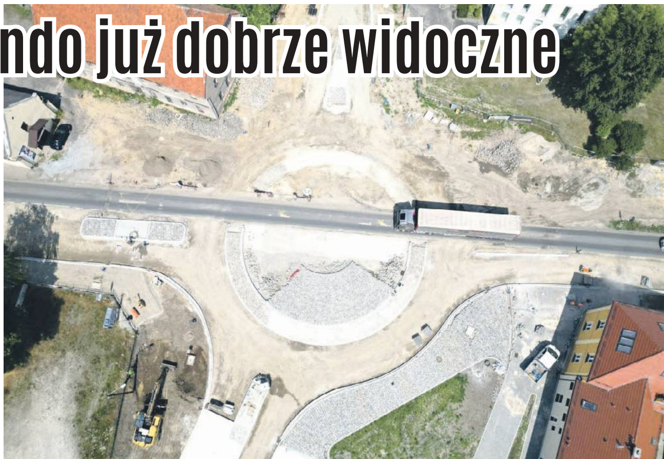
Z lotu ptaka rondo już dobrze widoczne
