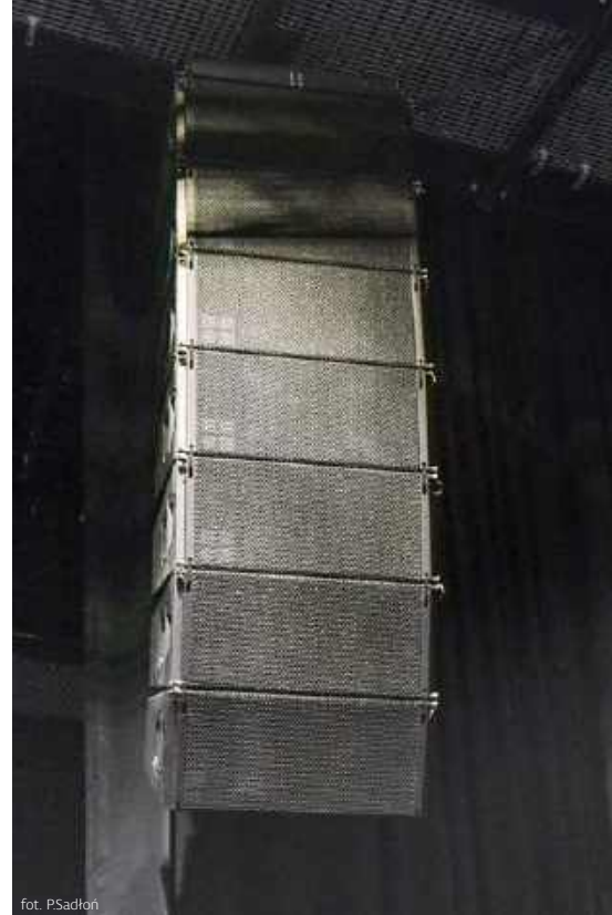
Nagłośnienie Sali Głównej Klubu Studio stanowi system liniowy d&b audiotechnik serii V.
