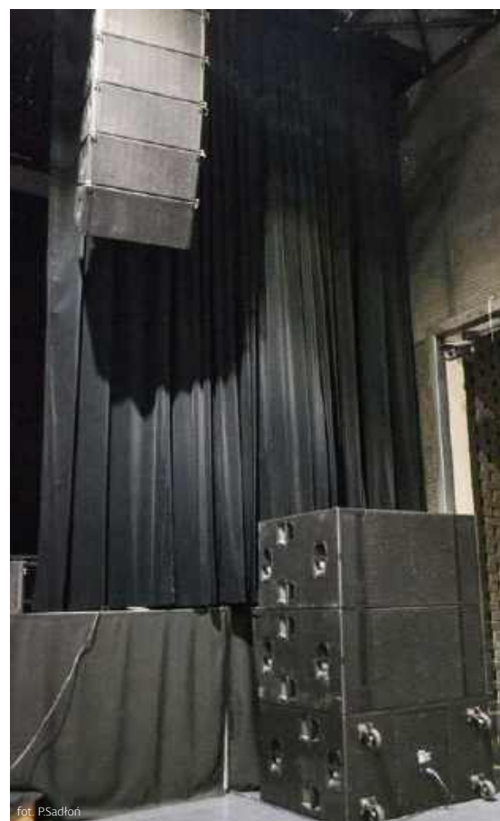
Uzupełnienie systemu w zakresie dolnych częstotliwości stanowi 6 subwooferów B22, które zazwyczaj są pod sceną, ale mogą być rekonfigurowane w zależności od wymagań danego wydarzenia.
