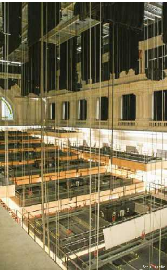
Ruchomy sufit stanowi 15 elementów rozlokowanych wzdłuż sali, z których każdy składa się z trzech wielkich kasetonów.
