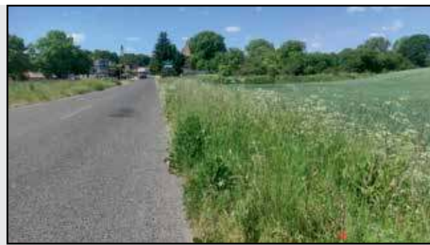
Pobocze drogi wojewódzkiej na terenie powiatu łobeskiego
