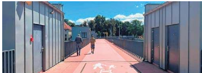
Mieszkańcy Nysy mogą już korzystać z nowej kładki.
