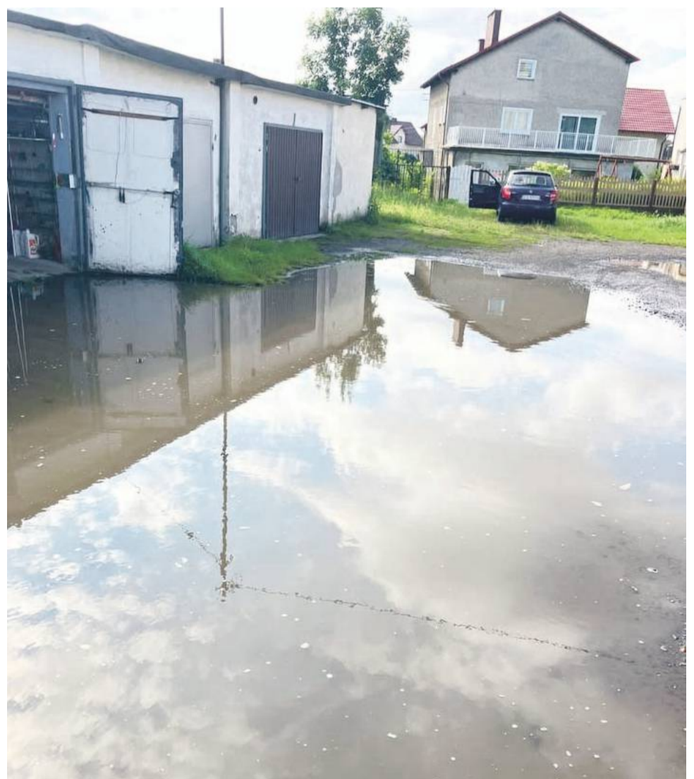
Tak po deszczu wygląda plac przed wejściem do garaży przy ul. Oleśnickiej
