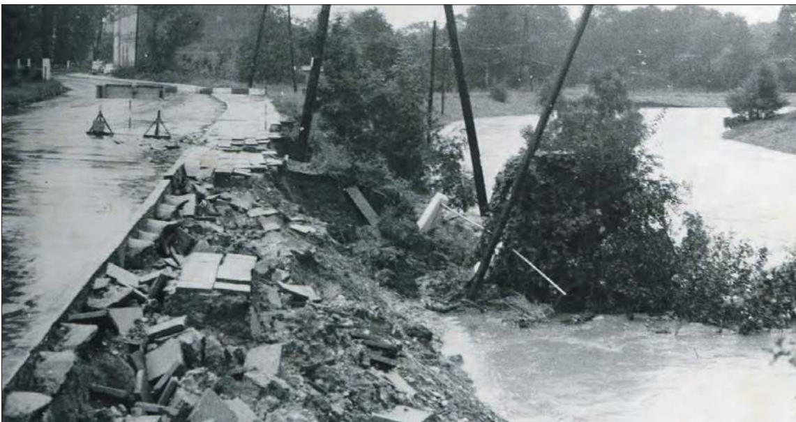
Rzeka zaczęła podcinać brzeg przy ul. Kolejowej (1977)
