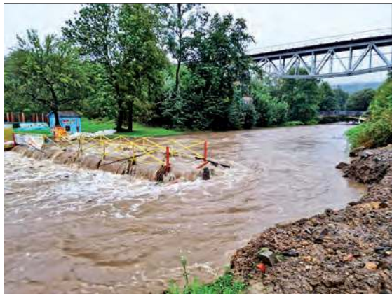
Kładka przy moście kolejowym w Moszczance nie przetrwała. Woda z rzeki wdarła się na teren sąsiedniego łowiska.
