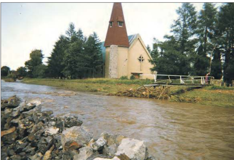
Wysoka woda niszczy kładki na Żłotym Potoku (1997)
