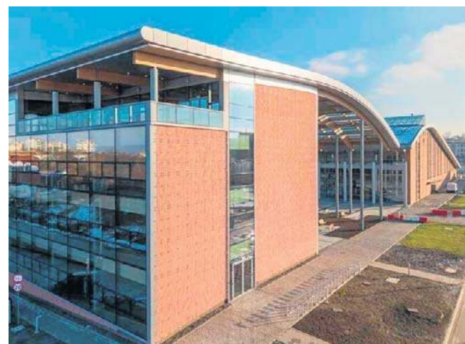
Nowy budynek dydaktyczny UPJPII połączony z biblioteką
