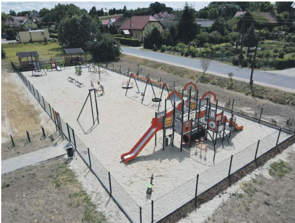
Prawie 600 tys. zł kosztowała budowa tego placu zabaw. Kulisy są kontrowersyjne
