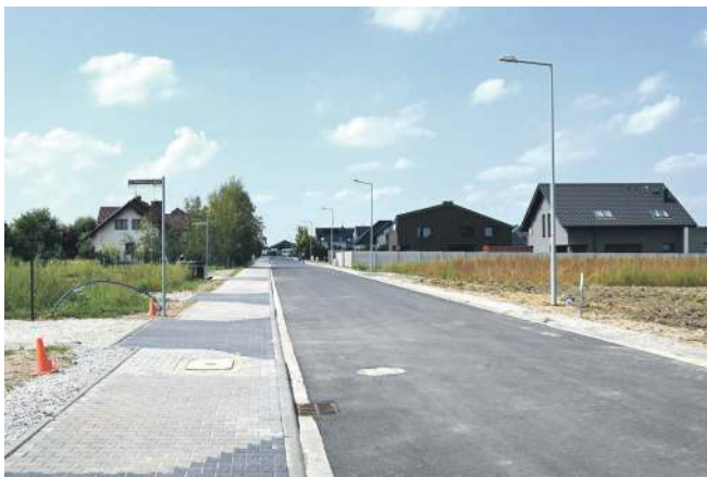
W Krynicznie zakończono przebudowę ul. Wiosennej
