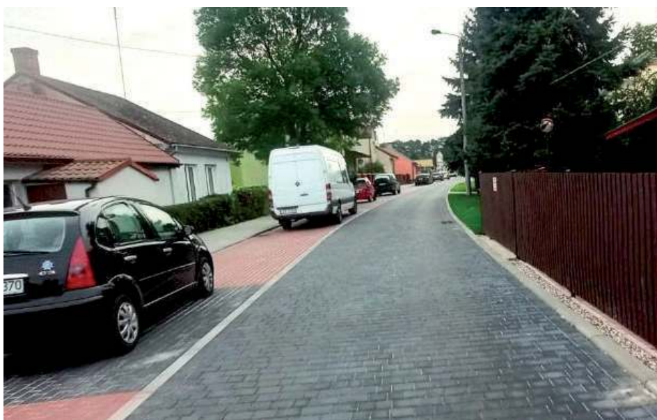
Fragment ulicy Nadwalnej został w ubiegłym roku wyremontowany
