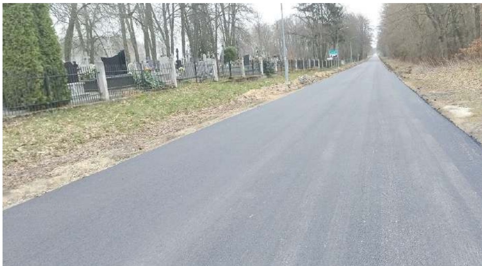
To nie koniec prac drogowych na terenie gminy, w planach są kolejne odcinki
