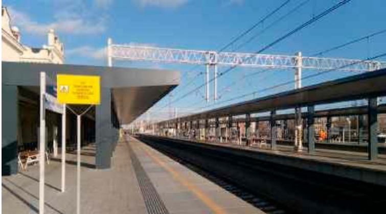
Nowe perony na dworcu Lublin Główny
