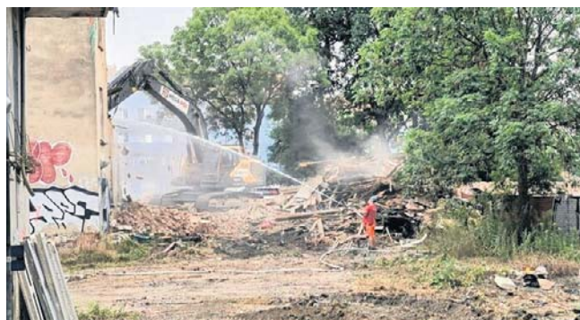
Polewanie rozbiieranych ścian wodą niewiele daje
